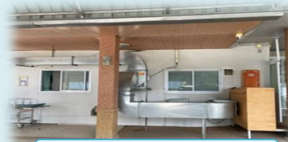
ระบบแรงลมดูด
